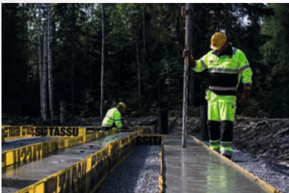
Po ewentualnym zamontowaniu zbrojenia dodatkowego, formy fundamentowe należy zalać betonem. Powierzchnię betonu można wyrównać do odpowiedniego poziomu.
