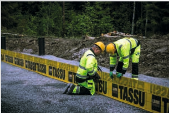
Formy fundamentowe TASSU montuje się na wcześniej wyrównanym i utwardzonym podłożu.
