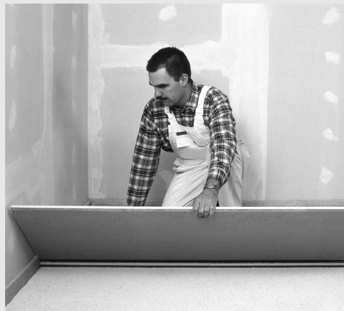
Obraz 43: element jastrychowy fermacell – tłumiący dźwięki uderzeniowe i izolujący termicznie. Wymiary 150 x 50 cm. Dostarczany w dziewięciu różnych grubościach i z różnymi materiałami izolacyjnymi.
