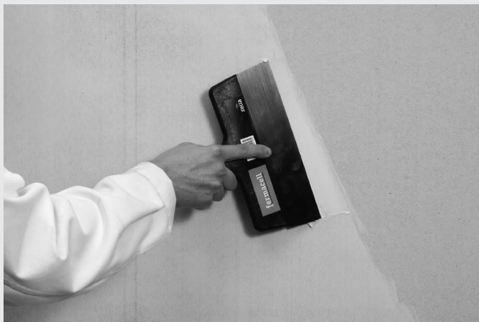
Rysunek 39: szpachlowanie powierzchni płyt gipsowo-włóknowych fermacell
