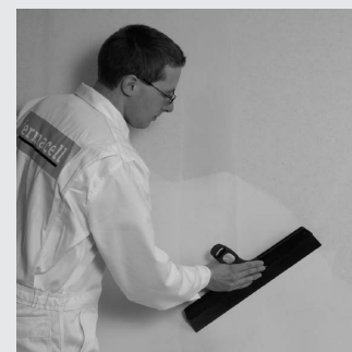
Rysunek 38: szpachlowanie finalną masą szpachlową fermacell i gipsową masą szpachlową fermacell do szpachlowania powierzchni
