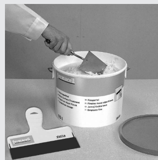
Rysunek 38: szpachlowanie finalną masą szpachlową fermacell i gipsową masą szpachlową fermacell do szpachlowania powierzchni
