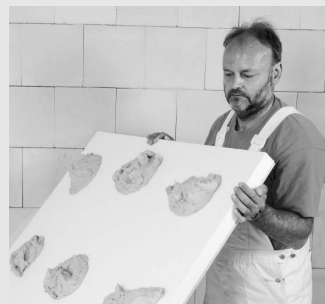
Obraz 44: płyta zespolona fermacell do izolacji termicznej. Wymiary 150 x 100 cm. Dostarczana w dwóch różnych grubościach.
