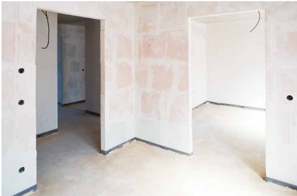
Rys. 15. Prawidłowe rozmieszczenie płyt w strefie ponad otworem drzwiowym
